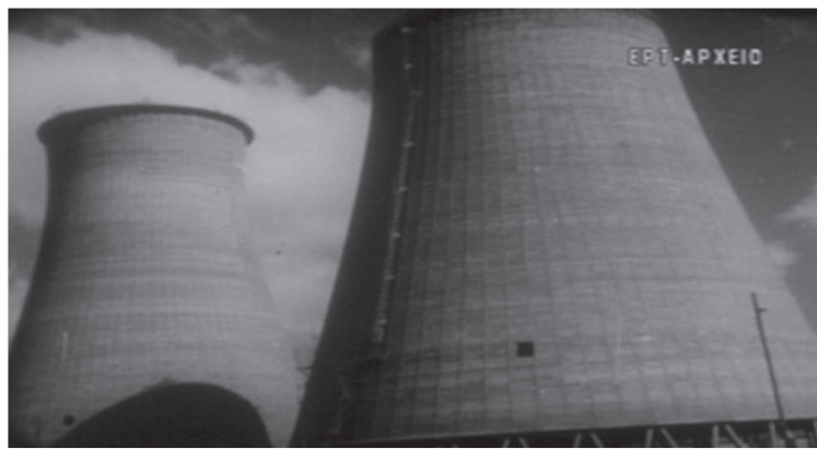
Εργοτάξιο της 2 ης ΜΟΜΑ για την κατασκευή εργοστασίου αζωτούχων λιπασμάτων.
