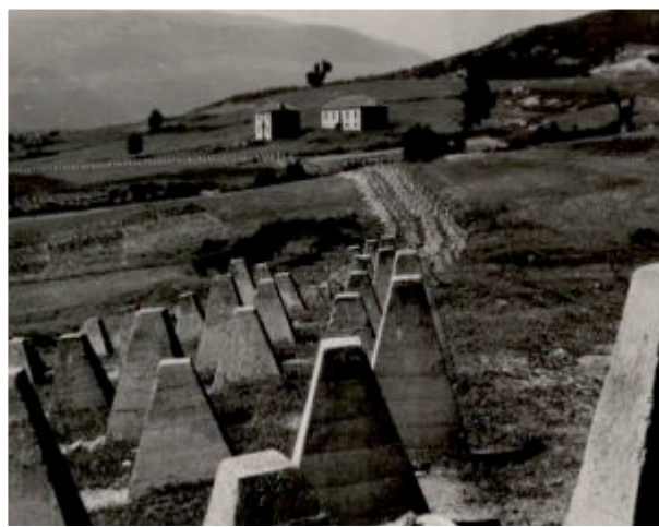
Αντιαρματικά (Α-Τ) κωλύματα οχυρού Παρταλούσκας (πεσσοί σκυροδέματος)
