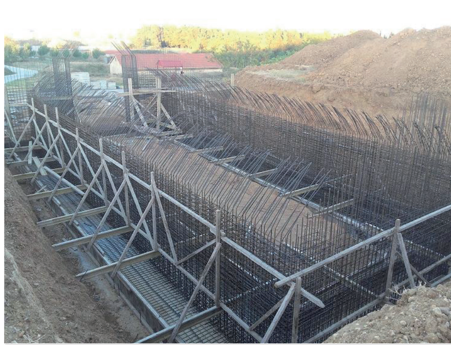
Κατασκευή αποθηκών πυρομαχικών στο εδαφικό διαμέρισμα Θράκης
