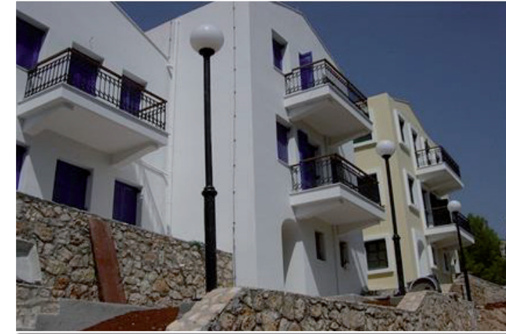
Κατασκευή ΣΟΑ και Λέσχης στη ν. Μεγίστη
