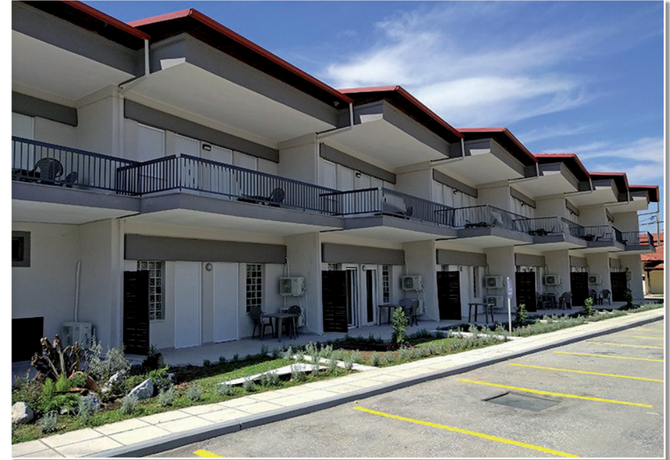
Ανακαίνιση διαμερισμάτων στο ΚΑΑΥ Αγ. Τριάδας
