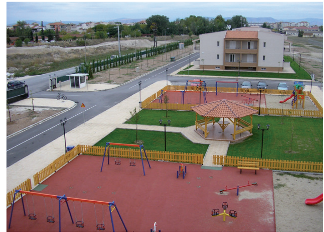
Κατασκευή συγκροτήματος κατοικιών και περιβάλλοντος χώρου στη Λάρισα
