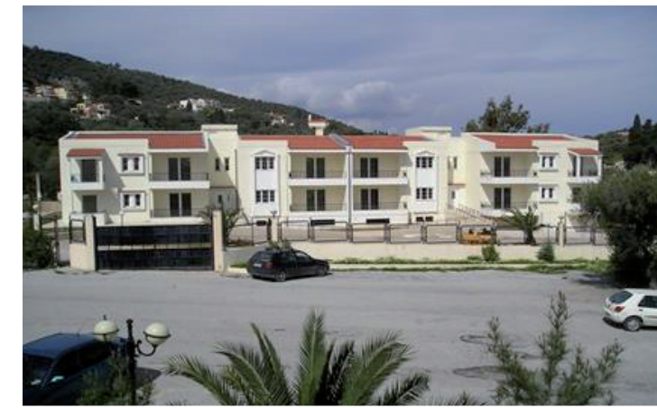
Κατασκευή ΣΟΑ στη Λέσβο
