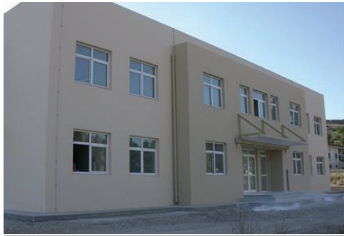
Κατασκευή Διοικητηρίου 2 ου ΤΥΑΔ
